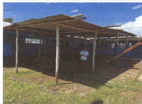
Foto 4: Sustitución de canal de pvc
