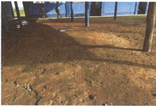
Foto 3: sustitucion de piso de concreto por torta de concreto
